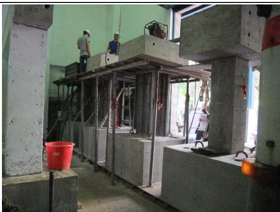
結構柱拆模
