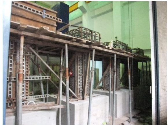
柱及頂部配筋
